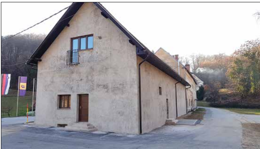
Kulturni dom Vurberk po izvedeni sanaciji
