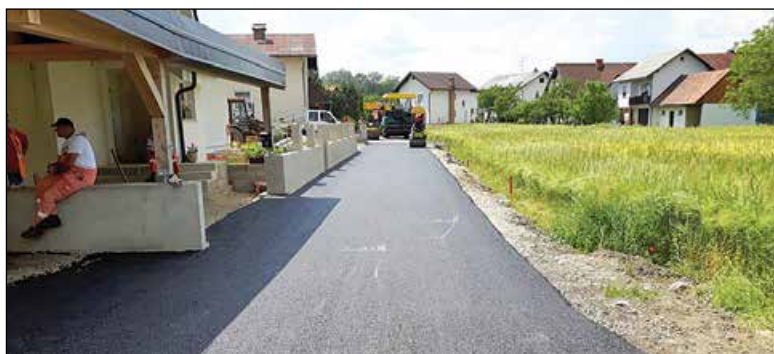
Asfaltirali smo makadamski del cestišča občinske javne poti št. JP 581570 Sp. Duplek (Bezgovje)
