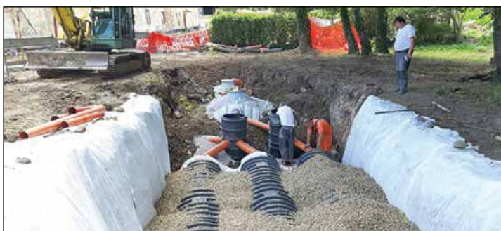
Zgradili smo kanalizacijsko omrežje z MČN in ponikovalnimi polji za večstanovanjske in druge objekte na naslovu Vurberk 90, 93, 95
