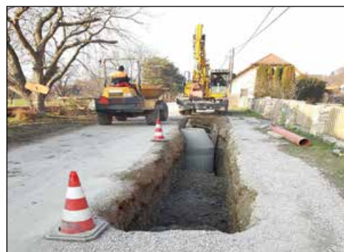
Gradimo primarno kanalizacijsko omrežje z dvema črpališčema v Zapolutkah v Zg. Dupleku
